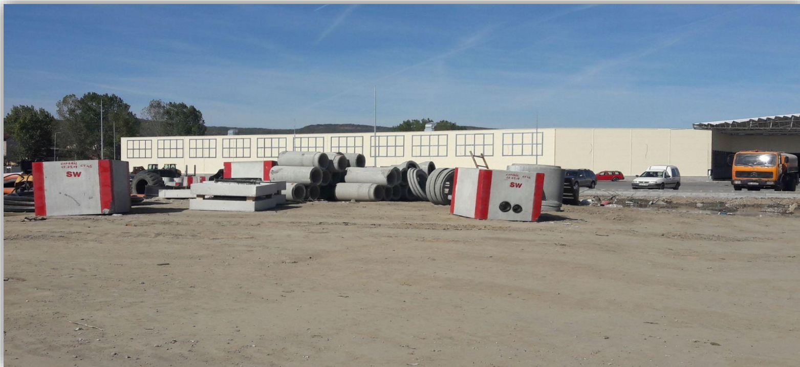
Camioane de tragere Fundatii stalpi de iluminat
