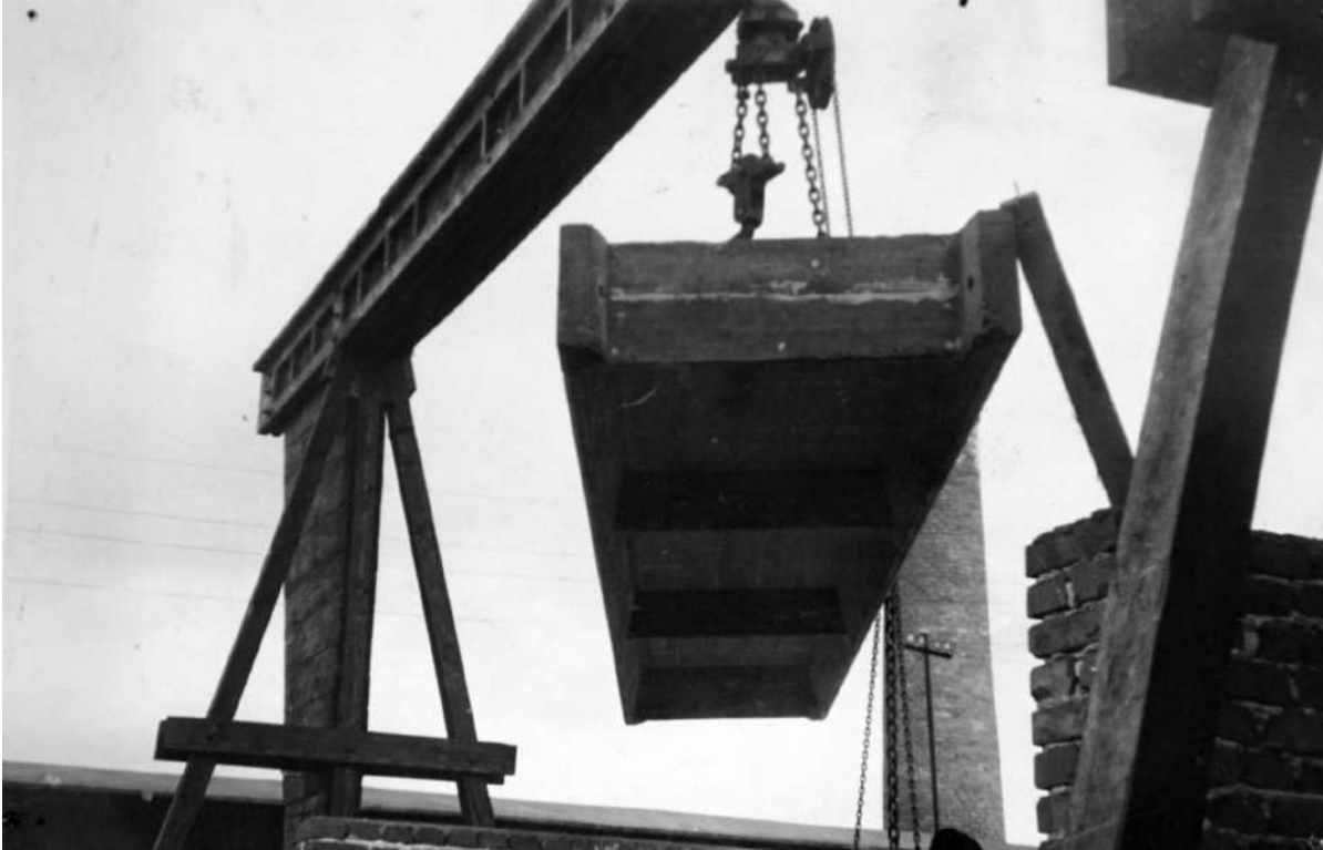
Placă prefabricată tip cheson
