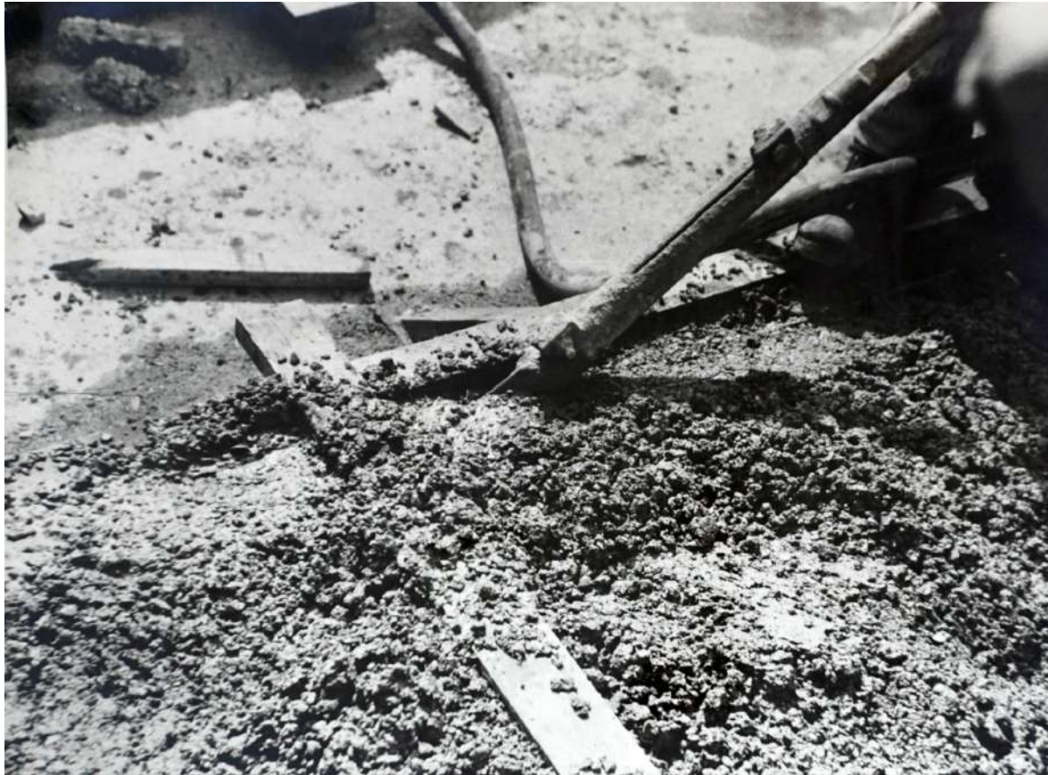
Detaliu de turnare cu ajutorul pervibratorului prevăzut cu lamă
