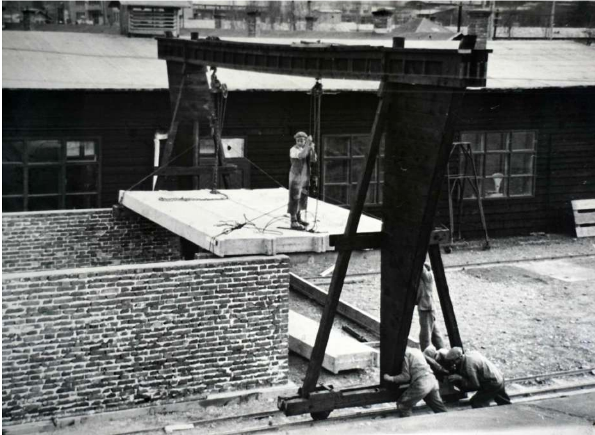
Fază din timpul montajului experimental
