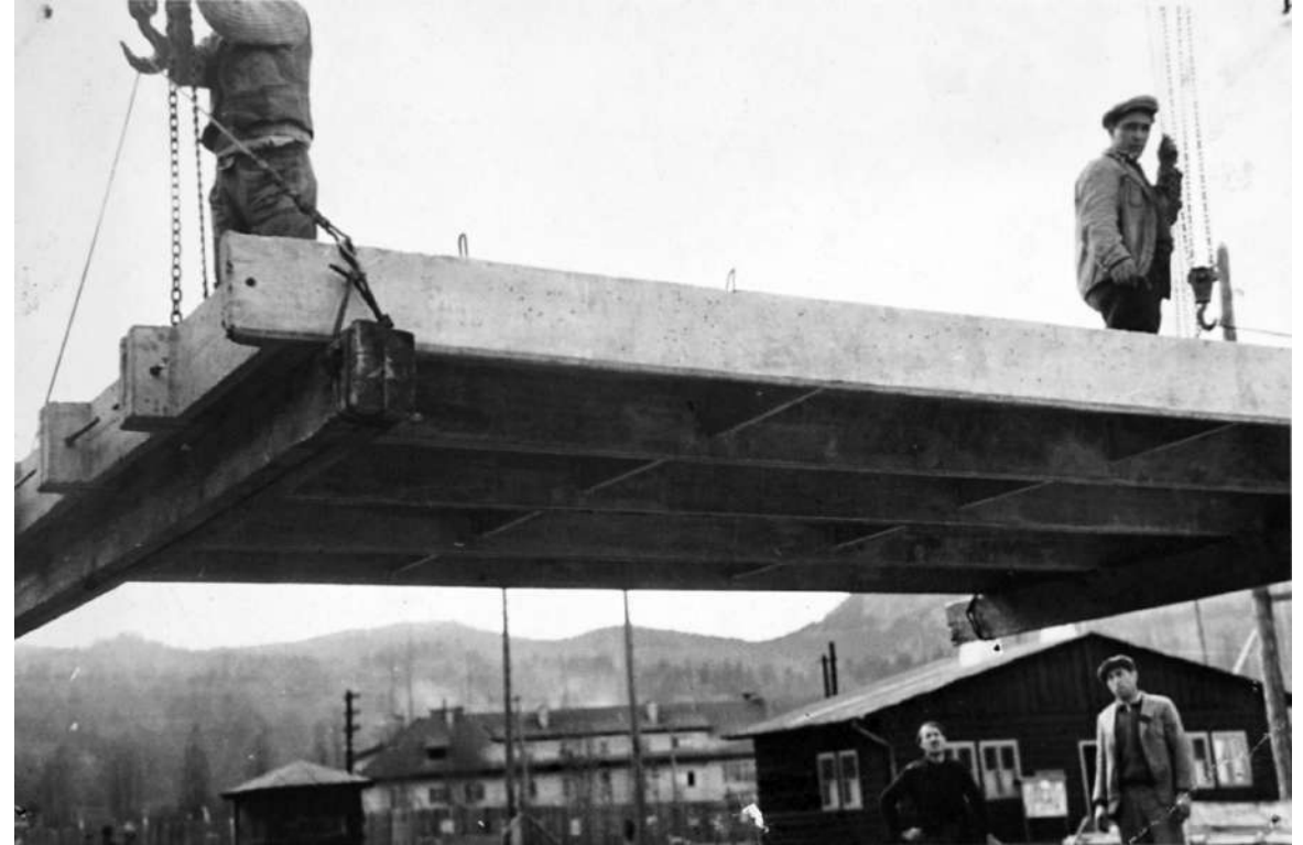
Planșeu prefabricat tip cheson de 20 mp în timpul montajului experimental
