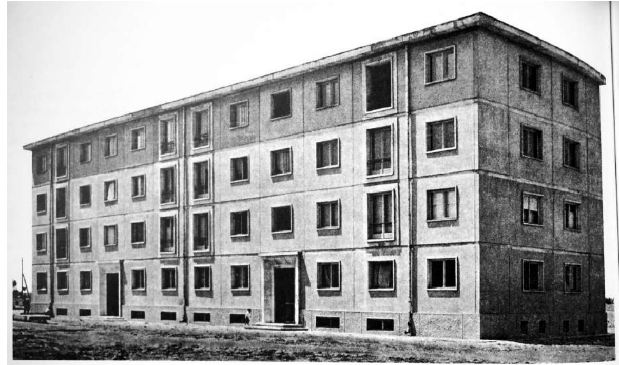
Bloc experimental din panouri mari, Șoseaua Giurgiului, 1956
