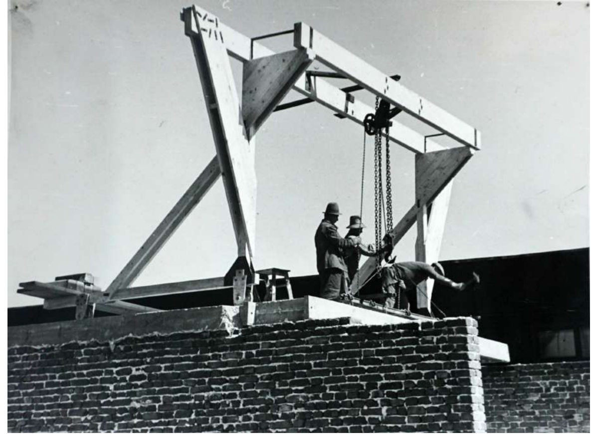
Macara tip trotinetă pentru montajul plăcilor cheson
