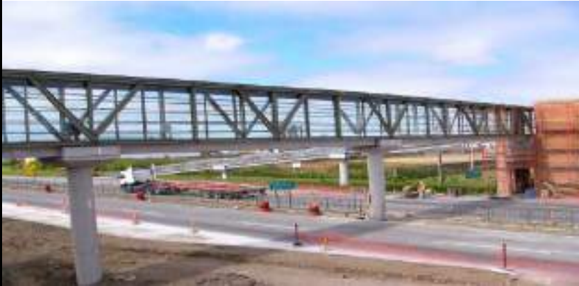
2004 – VIII Región Pasarela Brisas del Sol
